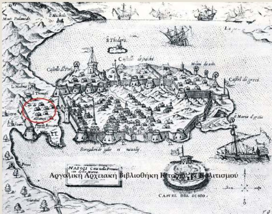
Χάρτης του Ναυπλίου του 1573; Διακρίνεται η τάφρος που χώριζε την πόλη από το βουνό του Παλαμηνδιού. Δυτικά στην άκρη της τάφρου διακρίνεται η σημείωση «Case Albanesi». Προφανώς οικισμός στον οποίο είχαν εγκατασταθεί Αλβανοί
