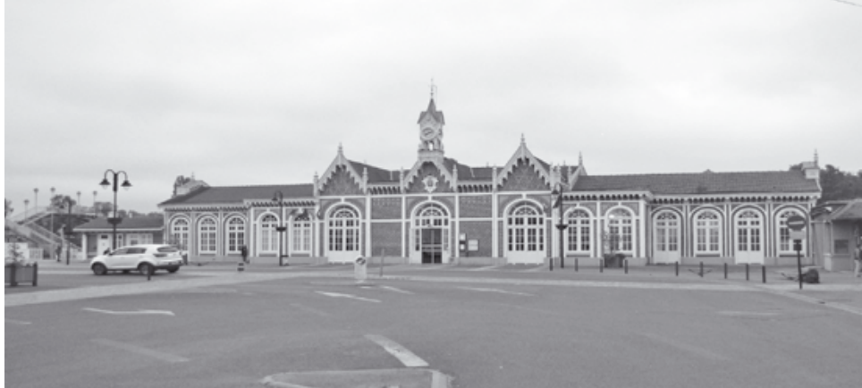
1912. Σιδηροδρομικός Σταθμός της Abbeville.
